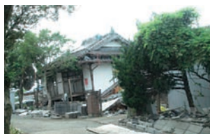
平成28年 熊本地震(益城町)
